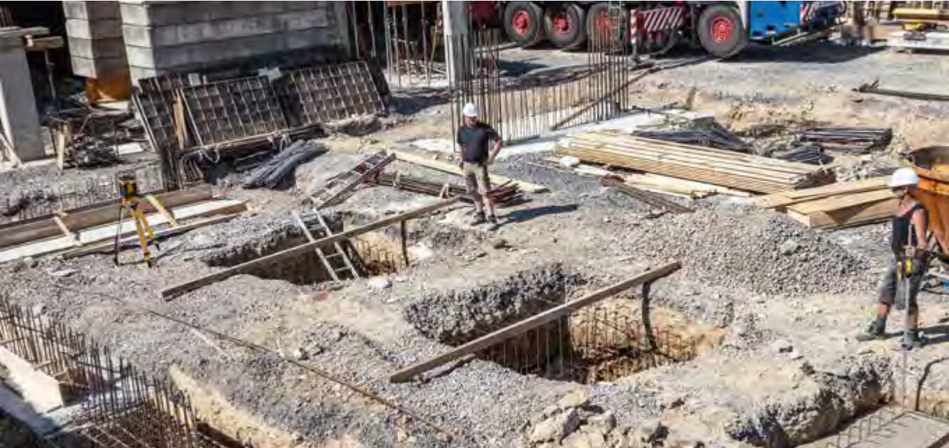
Лазерный прибор отличается удобным управлением и в комплекте с цифровым ресивером REC 300 Digital обеспечивает быструю и надежную работу в диапазоне до 800 м.
